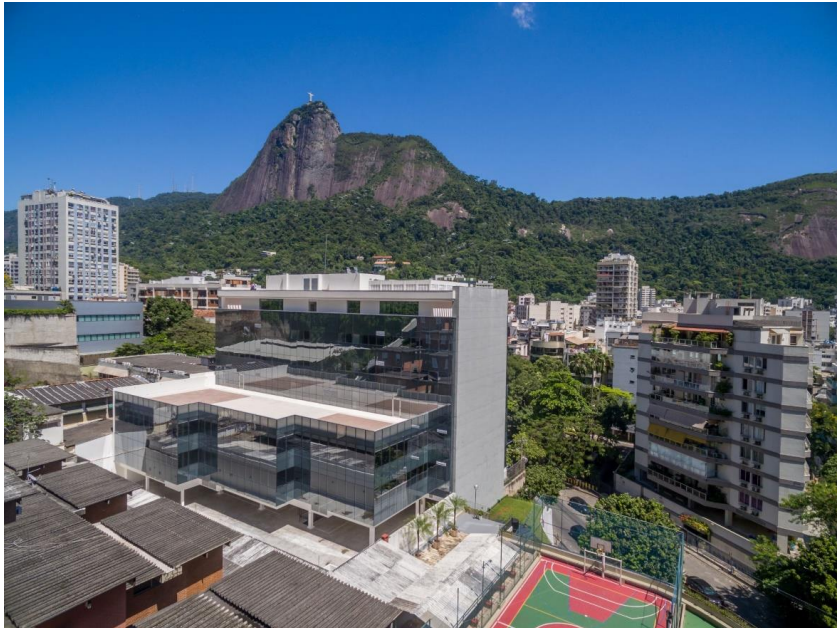
VISTA AÉREA DO EDIFÍCIO
