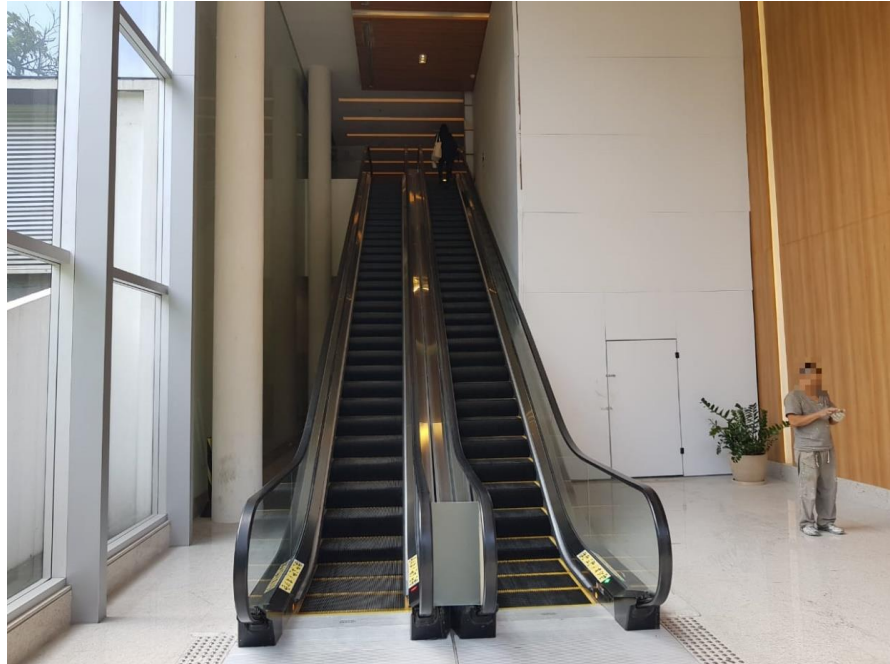
ESCADAS DE ACESSO À RECEPÇÃO
