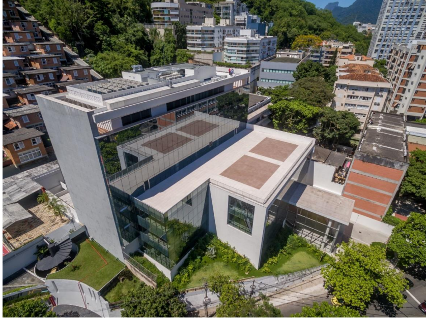
VISTA AÉREA DO EDIFÍCIO
