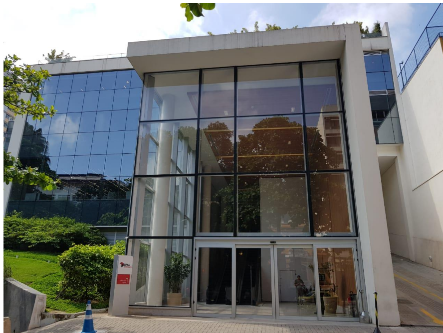
ENTRADA DO EDIFÍCIO
