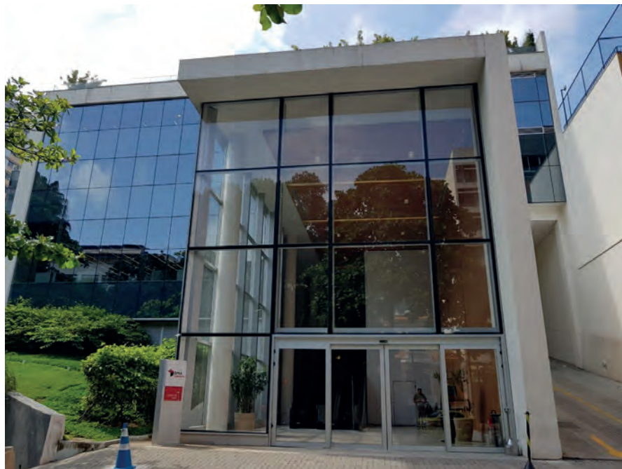
ENTRADA DO EDIFÍCIO
