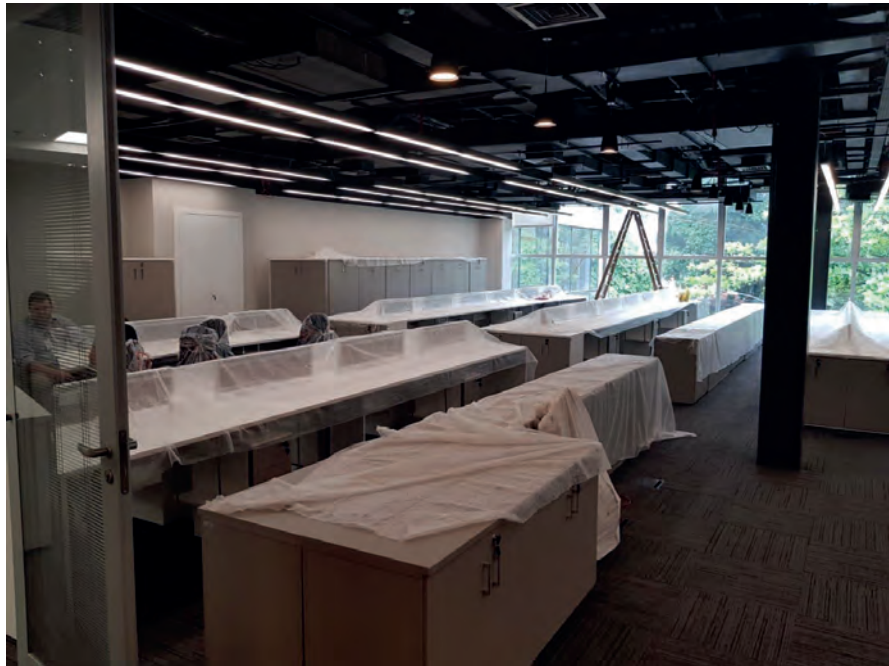
ÁREA DE ESCRITÓRIOS EM OBRAS – OCUPAÇÃO DA CSSJ
