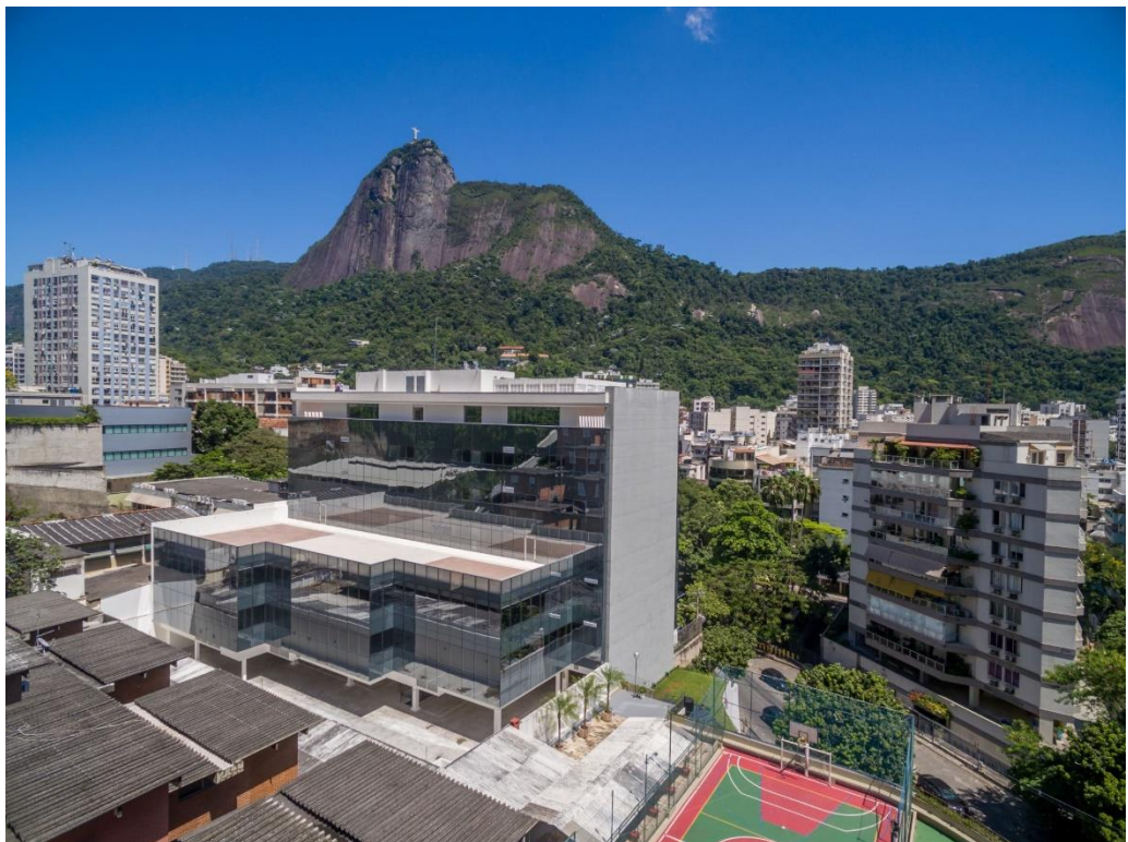
VISTA AÉREA DO EDIFÍCIO
