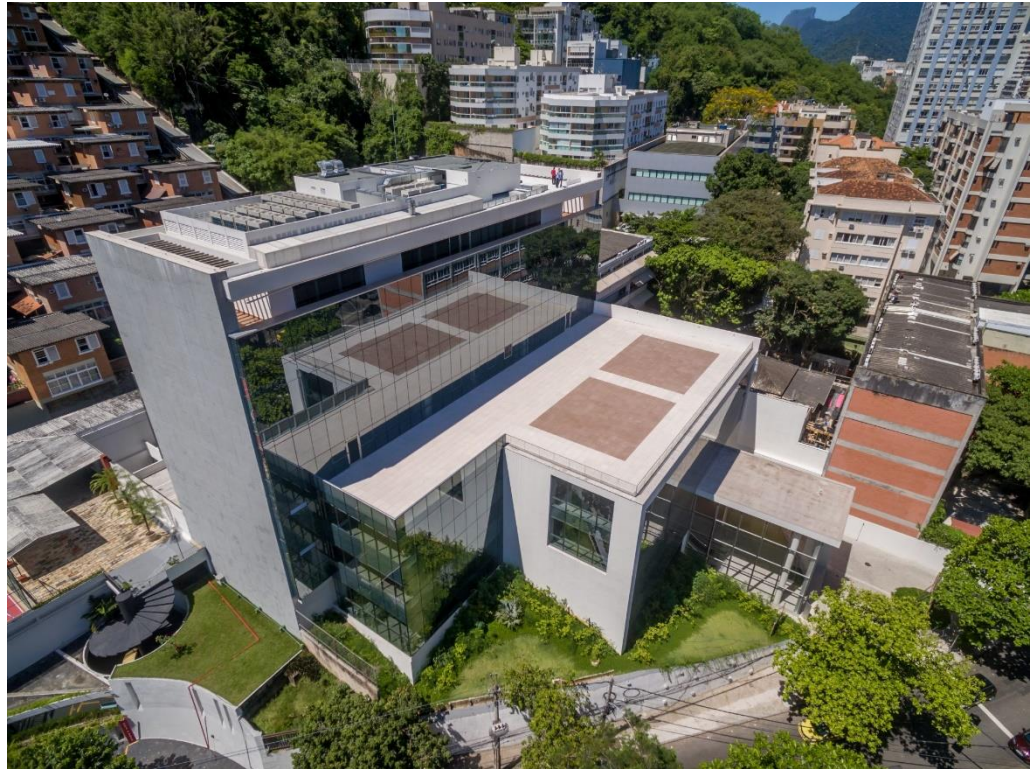
VISTA AÉREA DO EDIFÍCIO
