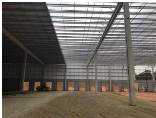
Instalação das telhas de cobertura metálica
