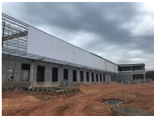
Fechamento vertical metálico em andamento
