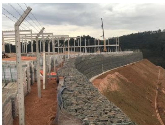
Muro e gabião finalizado, alambrado em execução
