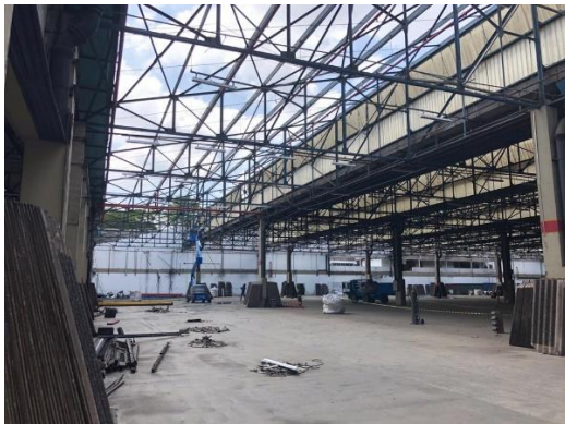
1. Troca da cobertura do galpão antigo, elevação do pé-direito para 12m
