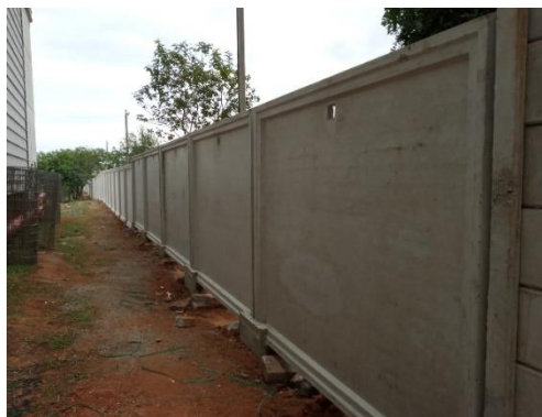
2. Fechamento com muros de concreto pré-moldado
