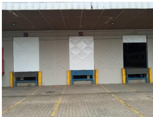
4. Pintura emborrachada na fachada das docas
