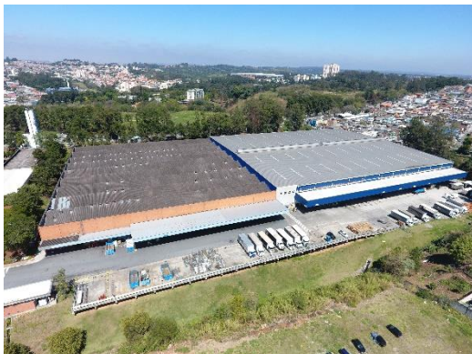
3. Vista aérea antes do retrofit
