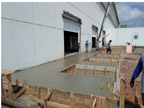
1. Concretagem novas docas piso polido
