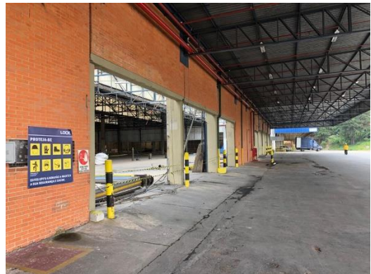
2. Obras na região das docas
