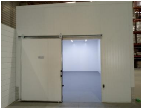
1. Execução de ala climatizada
