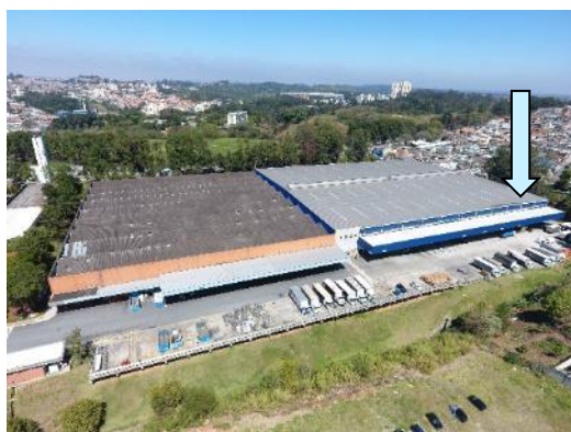
1. Vista aérea antes do retrofit
