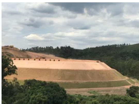
Área de aterro – finalização do talude
