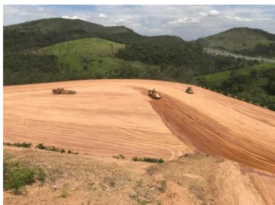
Vista superior do aterro
