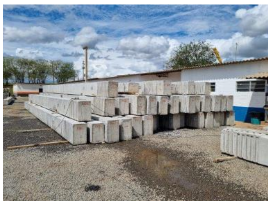
Pilares pré-moldados já armazenados no canteiro
