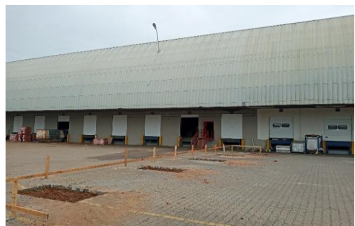
6. Fundações galpão de apoio
