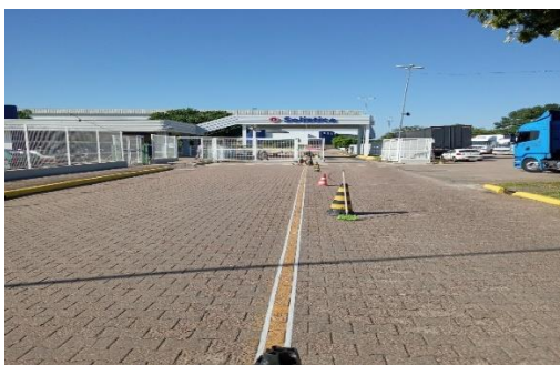
5. Nova demarcação viária
