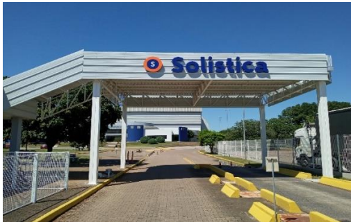
1. Novo pórtico da portaria
