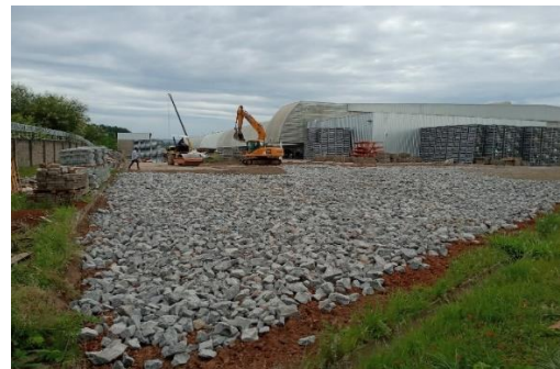
4. Preparo de subleito – piso intertravado
