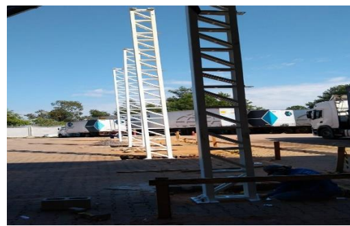
6. Fundações galpão de apoio instaladas
