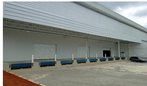
4. Novas docas com niveladoras instaladas
