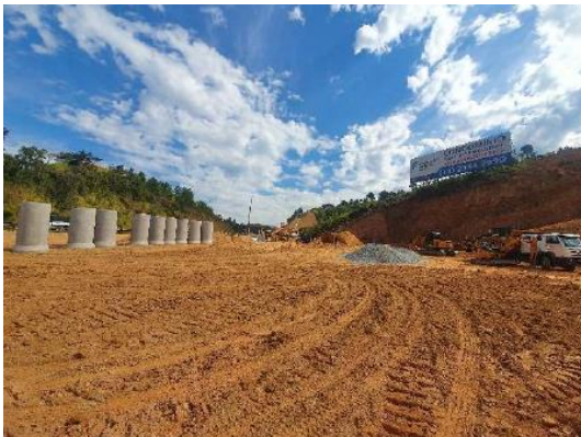
Acesso viário – visão geral
