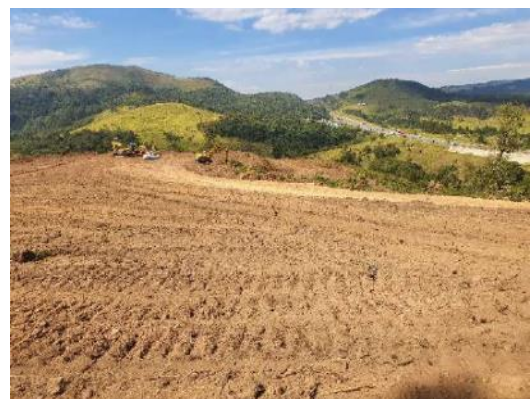
Terraplenagem em andamento
