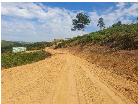
Terraplenagem – trecho de acesso das máquinas
