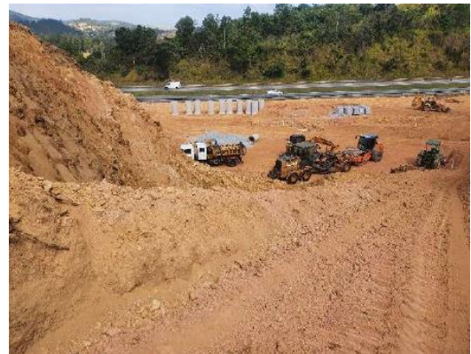
Acesso viário – visão geral
