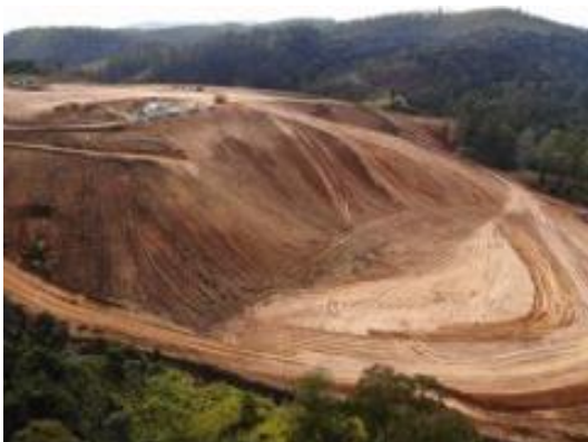
Terraplenagem – trecho de acesso das máquinas
