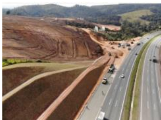
Terraplenagem em andamento
