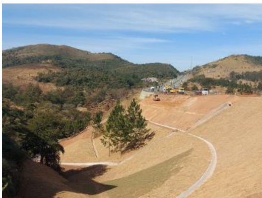
Talude e drenagem em área frontal do terreno
