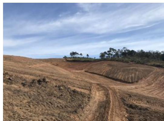
Terraplenagem em andamento
