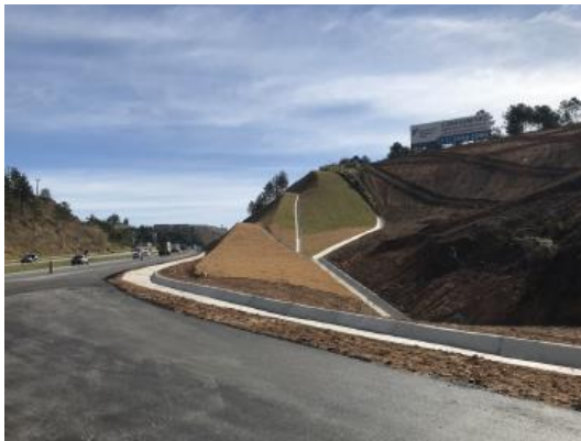
Acesso viário e talude – entrada terreno
