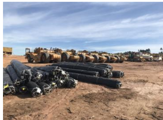
Equipamentos para terraplanagem e arrimos
