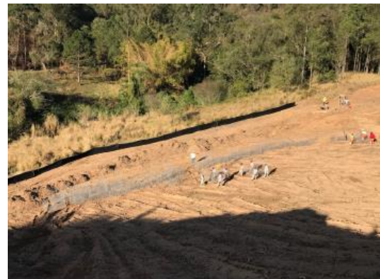
Execução dos muros de arrimo
