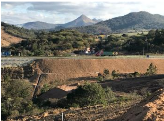
Taludes concluídos, acesso ao terreno
