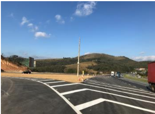
Acesso – faixas de aceleração e desaceleração
