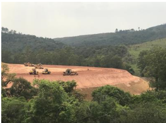
Talude em área interna com plantio de gramado
