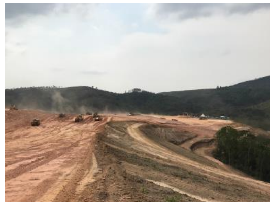
Vista da área de corte do terreno
