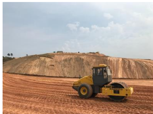
Vista da área de aterro do terreno
