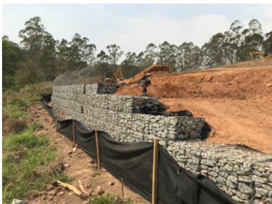
Muros de arrimo em execução
