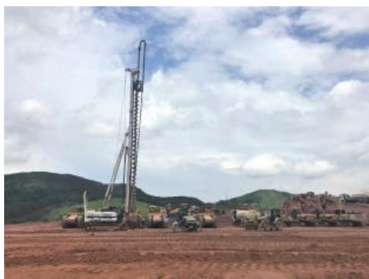
Execução de estaca
