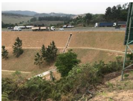
Talude com escada hidráulica concluído
