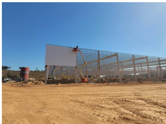
Lateral do galpão com início do fechamento
