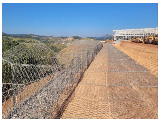
Muro de gabião da lateral do empreendimento
