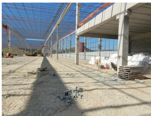
Preparação para execução do piso
