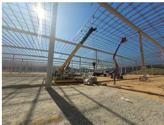
Cobertura metálica em desenvolvimento
