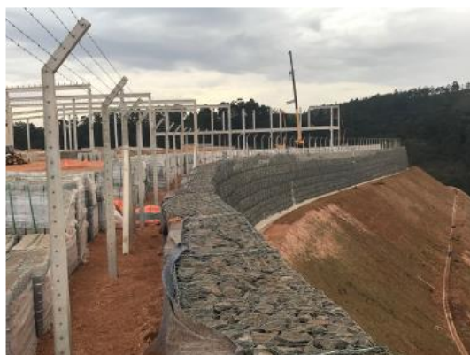
Muro e gabião finalizado, alambrado em execução
