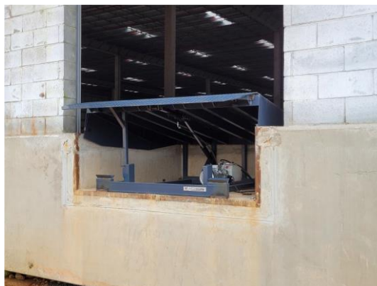
Instalação das niveladores e porta de docas
