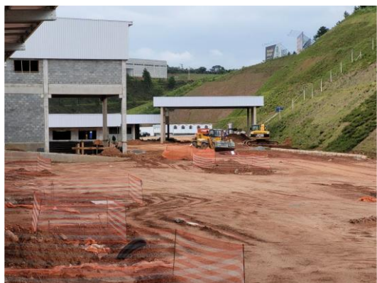
Área externa e estacionamento
