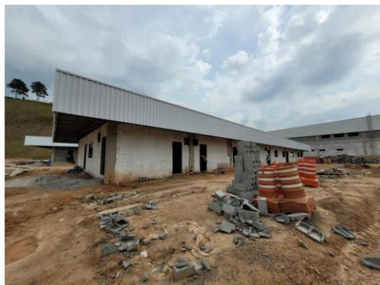
Área de apoio (refeitório)
