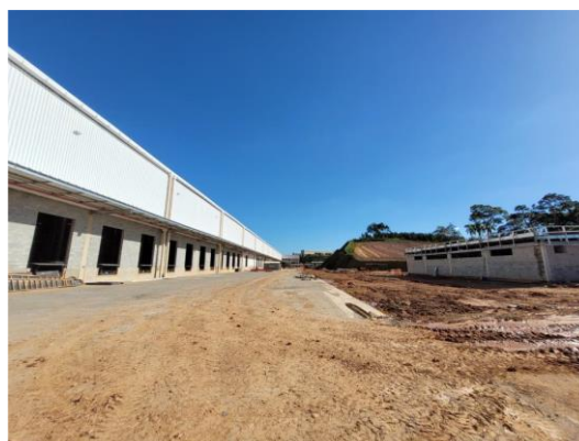
Vista lateral, vestiário em construção
