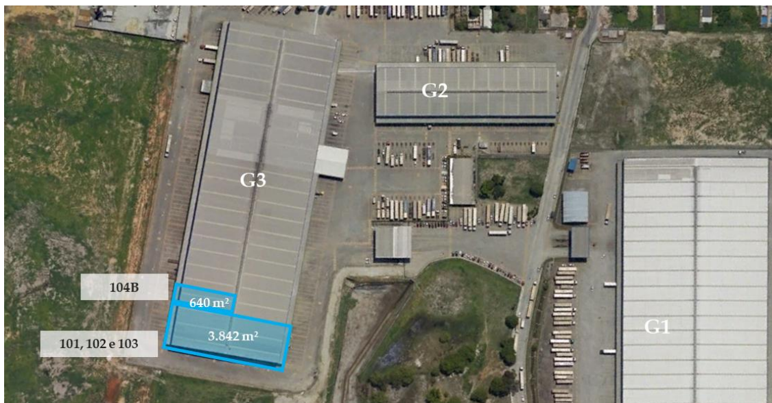
Locações no Galpão G3 do Caxias Park, módulos 104-A e módulos 105, 106 e 10, totalizando 4.482m 2
