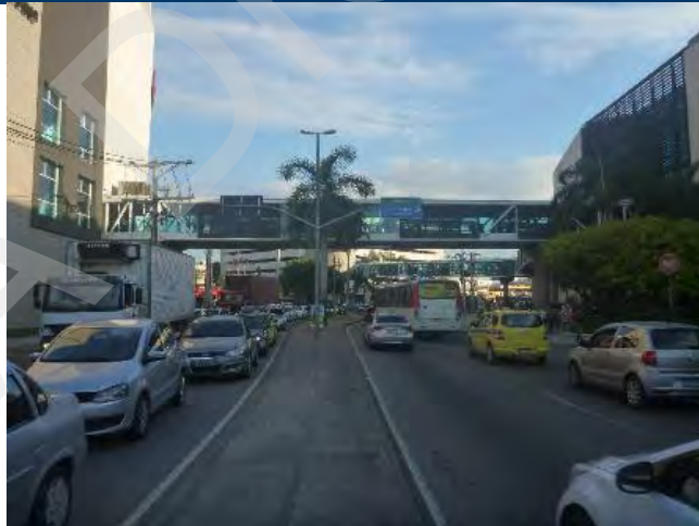
ASPECTO DO ACESSO AO WEST SHOPPING CENTER - EDIFÍCIO MATRIZ – ESTRADA DO MENDANHA
