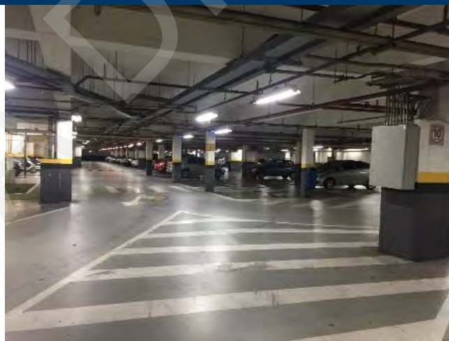
ASPECTO INTERNO DO AVALIANDO – PISO G1 – GARAGEM
