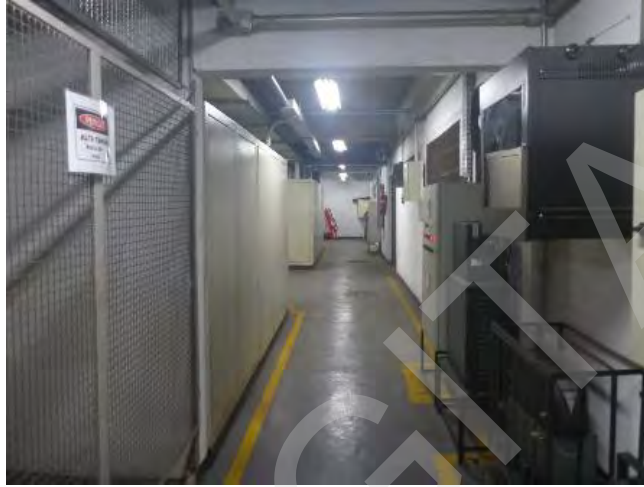
ASPECTO INTERNO – PISO G1 – ÁREA TÉCNICA
