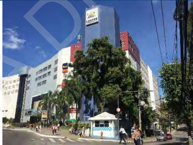
ASPECTO DA FACHADA DO AVALIANDO – AVENIDA GEREMÁRIO DANTAS X RUA LAURA TELES
