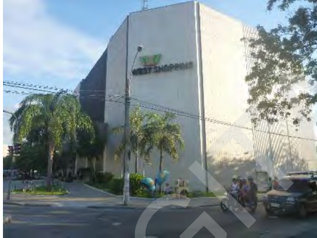
ASPECTO DA FACHADA DO AVALIANDO
