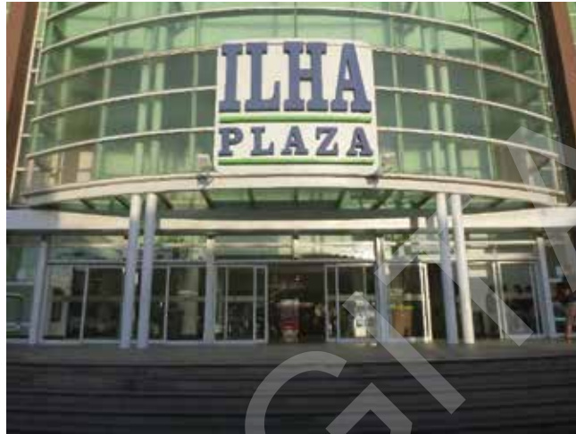
ASPECTO DA FACHADA DO AVALIANDO – FRENTE
