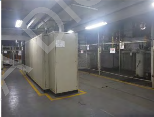
ASPECTO INTERNO – PISO G1 – ÁREA TÉCNICA
