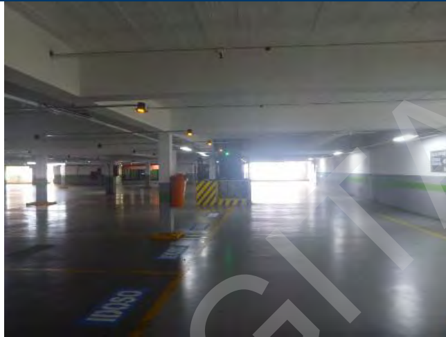
ASPECTO INTERNO – PISO G2 – GARAGEM DA FACULDADE ESTACIO
