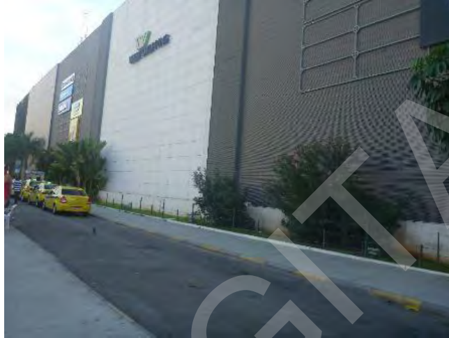
ASPECTO DA FACHADA DO AVALIANDO
