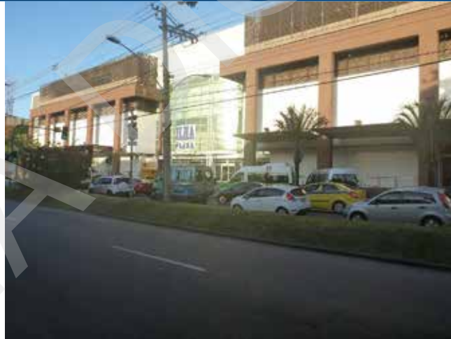
ASPECTO DA FACHADA DO AVALIANDO – FRENTE
