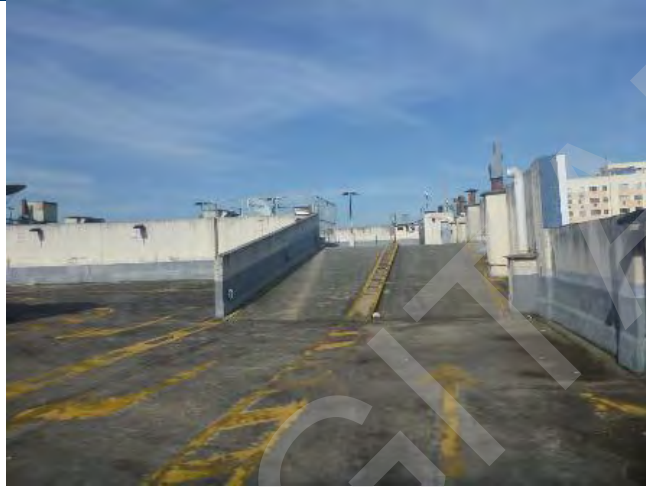
ASPECTO INTERNO DO AVALIANDO – COBERTURA – ÁREA TECNICA
