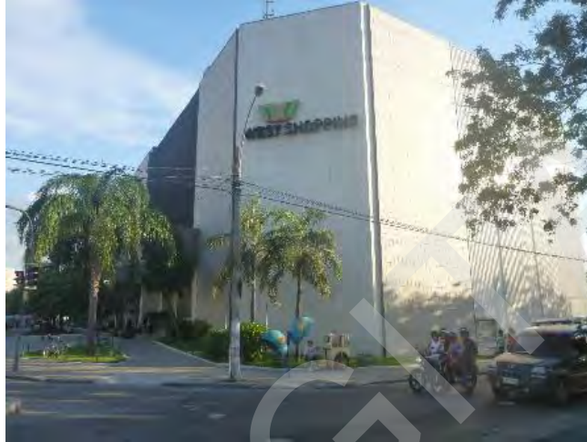
ASPECTO DA FACHADA DO AVALIANDO
