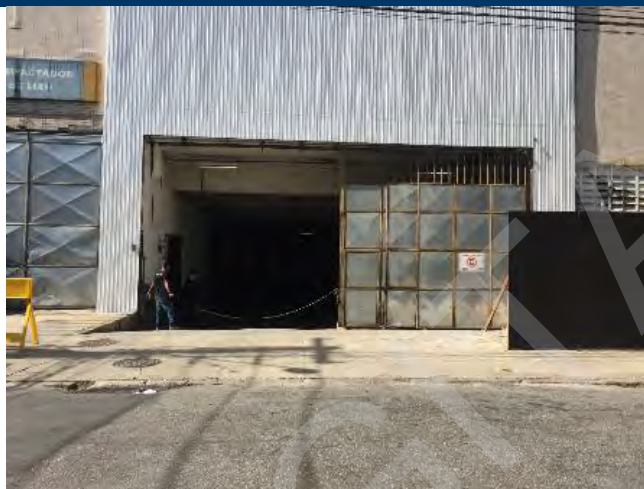
ASPECTO EXTERNA DA FACHADA DO AVALIANDO – PISO SS – SUBSOLO – DOCAS
