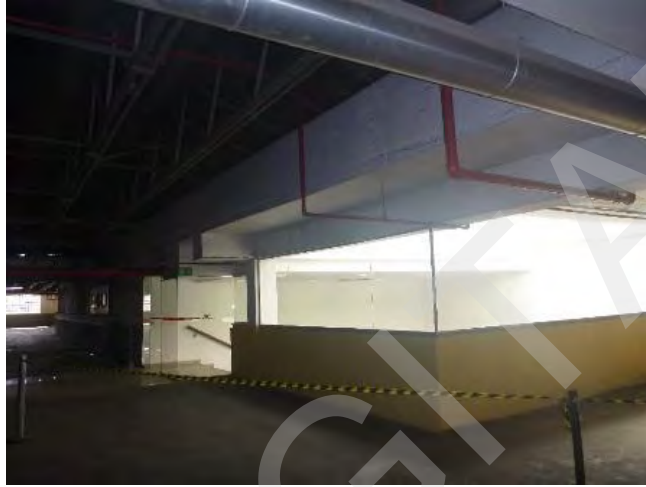
ASPECTO INTERNO – PISO G3 – ACESSO AS LOJAS
