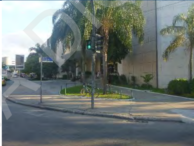
ASPECTO DA FACHADA DO AVALIANDO
