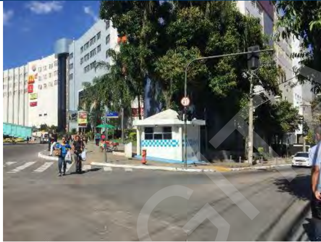
ASPECTO DA FACHADA DO AVALIANDO – AVENIDA GEREMÁRIO DANTAS X RUA LAURA TELES
