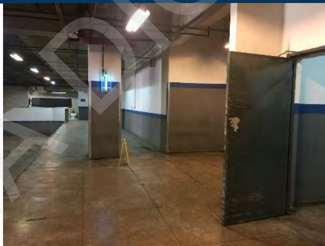
ASPECTO INTERNO DO AVALIANDO – PISO SS – SUBSOLO – DOCAS
