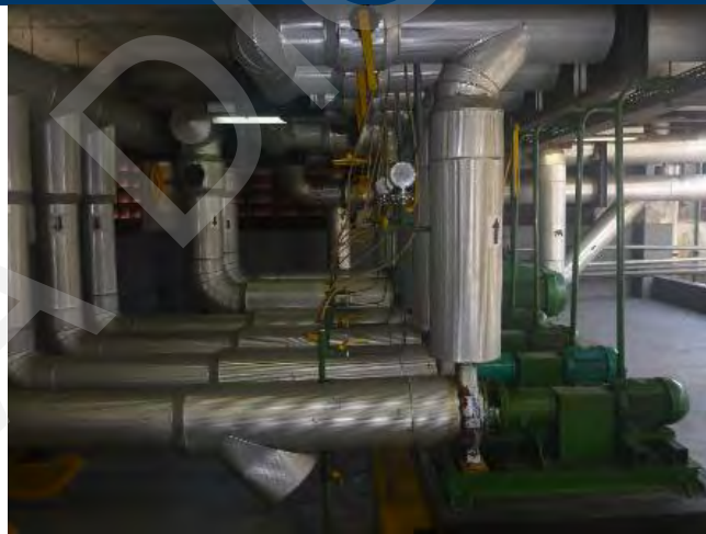
ASPECTO INTERNO DO AVALIANDO – COBERTURA – ÁREA TECNICA
