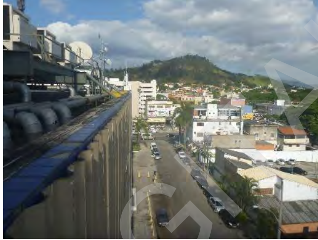
ASPECTO DO ACESSO AO WEST SHOPPING CENTER - EDIFÍCIO MATRIZ – RUA NOVA BETÂNIA
