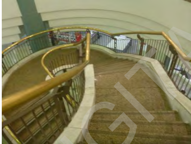
ASPECTO INTERNO – PISO L1 – ACESSO A ESCADA PARA O PISO SUPERIOR
