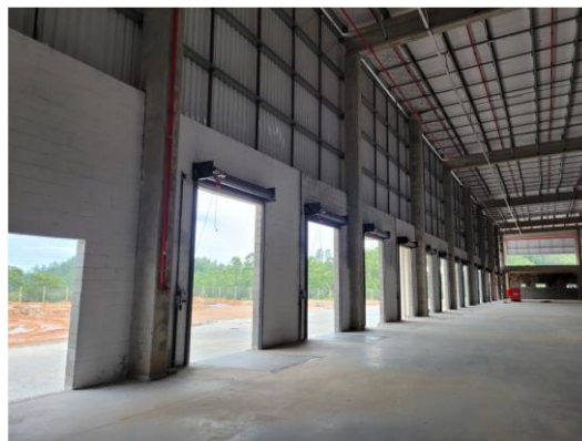
Instalação das portas das docas
