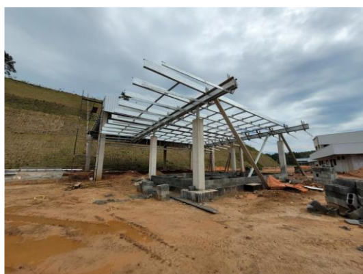
Guarita e portaria em execução
