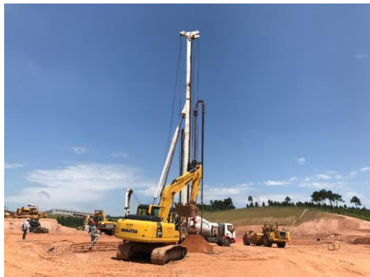
Execução de estacas e sapatas
