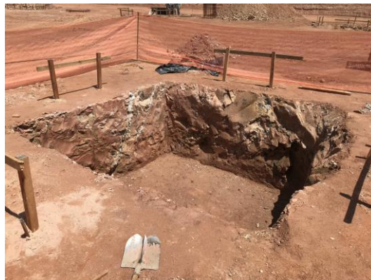
Escavação para execução de sapata
