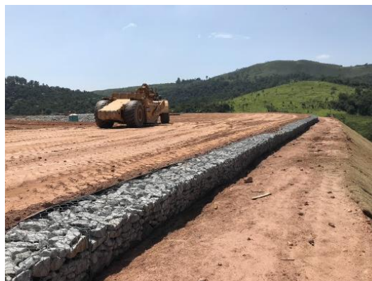
Execução de muro de arrimo tipo gabião
