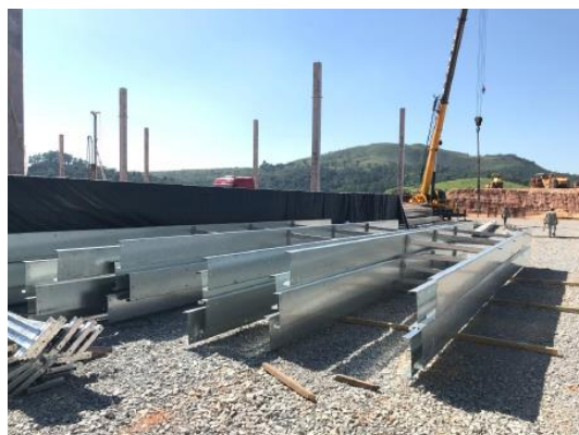
Pré-montagem das terças metálicas da cobertura
