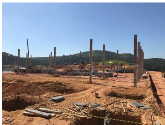
Execução superestrutura – pilares pré-moldados
