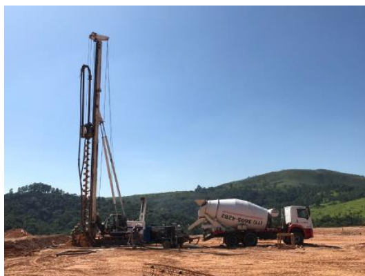
Execução de fundação – estacas
