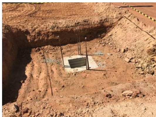
Execução de fundação – sapatas
