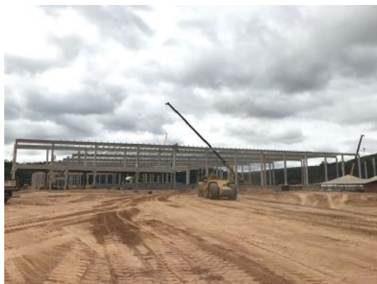
Pilares pré-moldados e estrutura da cobertura
