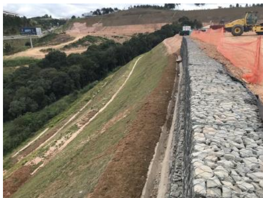
Execução de muro arrimo tipo gabião
