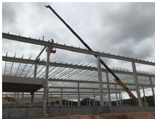
Execução da alvenaria de fechamento
