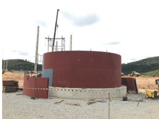
Execução do reservatório de água
