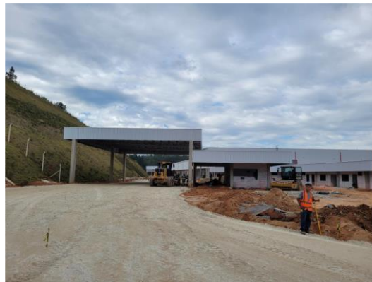
Pavimentação da entrada, portaria concluída
