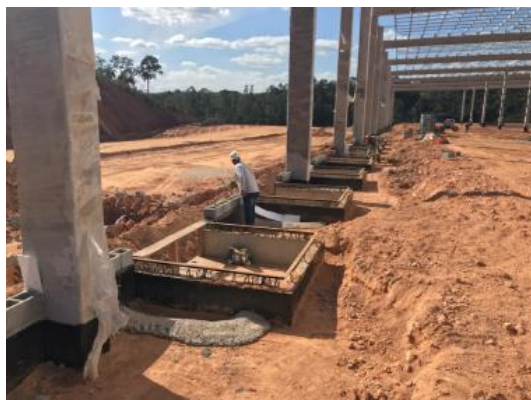
Instalação dos nichos das niveladoras de doca
