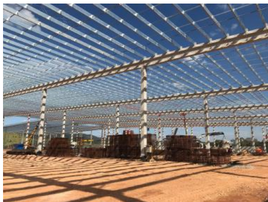
Estrutura do galpão e instalações em andamento
