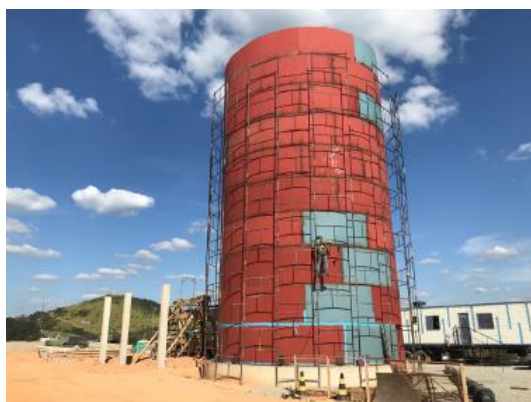
Execução do reservatório de água
