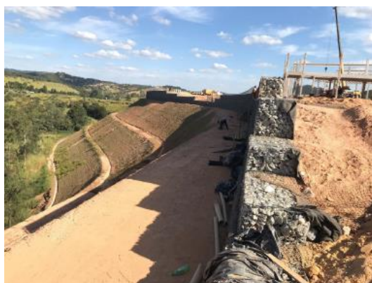
Execução de muro arrimo tipo gabião
