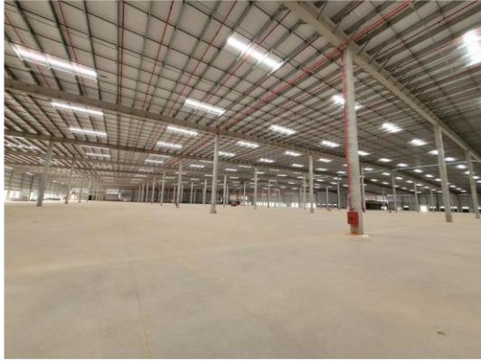
Vista interna do galpão, serviços concluídos
