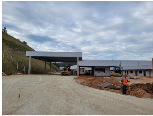
Pavimentação da entrada, portaria concluída
