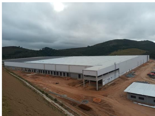
Vista geral do galpão
