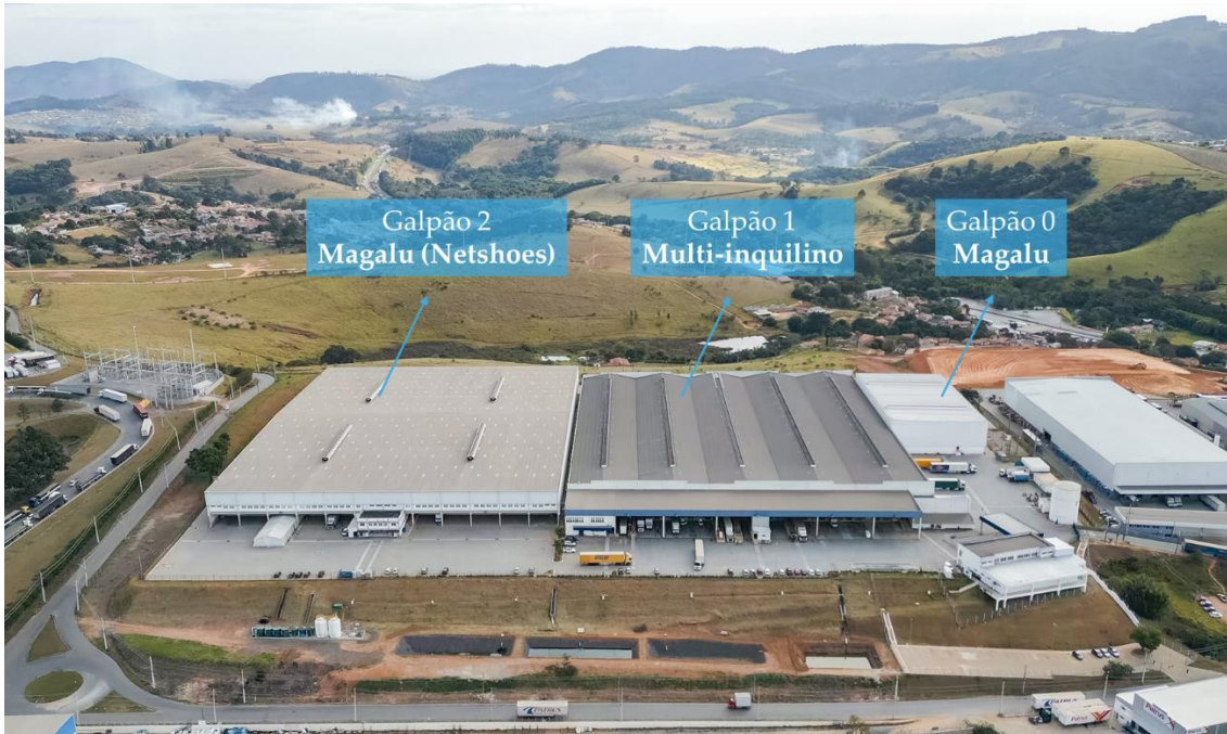
Vista aérea do condomínio logístico Fernão Dias Business Park, Extrema-MG
