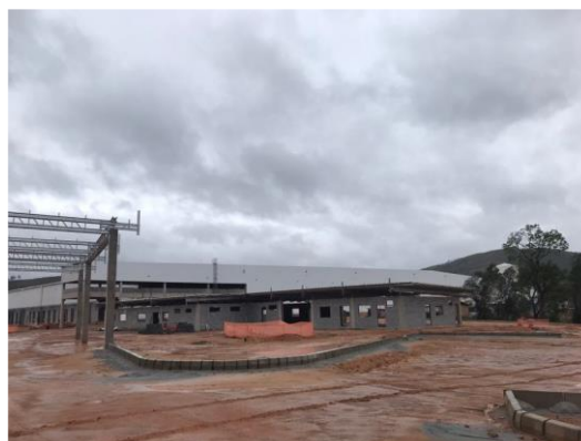
Demarcação de guias em acesso ao galpão
