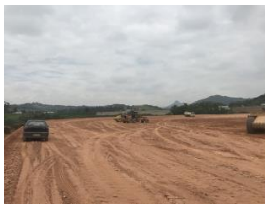
Vista da área de aterro do terreno
