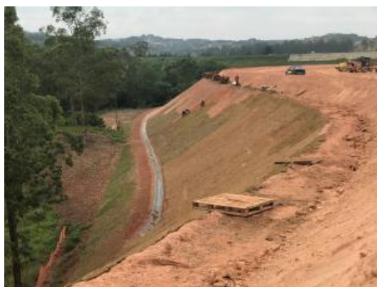
Plantio de gramado em talude
