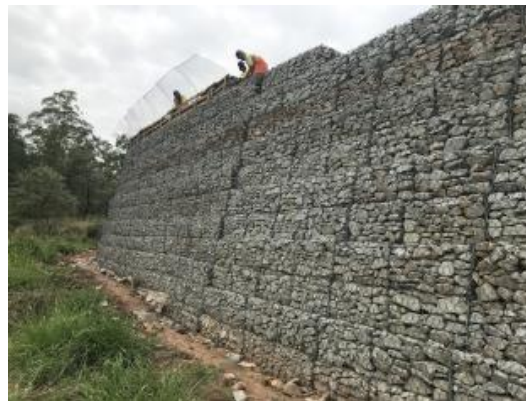
Execução de muro de arrimo
