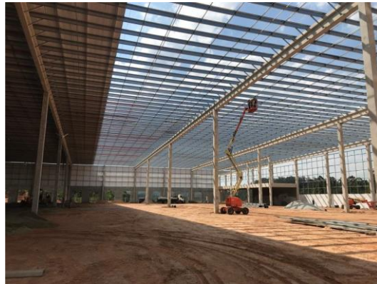
Instalação de telhas metálicas em andamento
