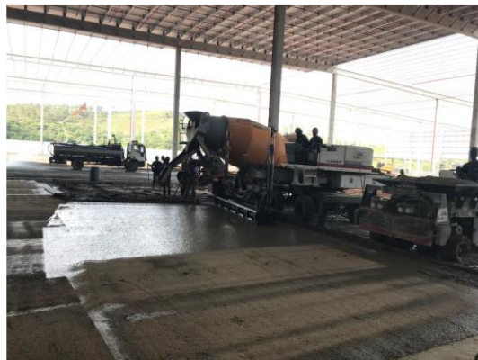
Piso industrial em execução
