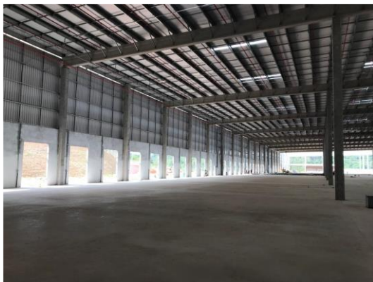
Vista interna do galpão, fachada e docas laterais
