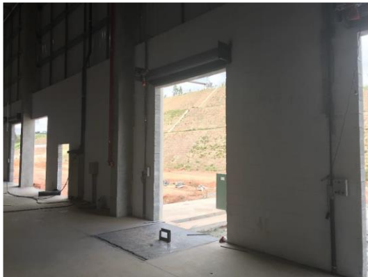
Instalação de niveladora e porta de doca
