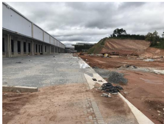
Execução de pavimentação das docas
