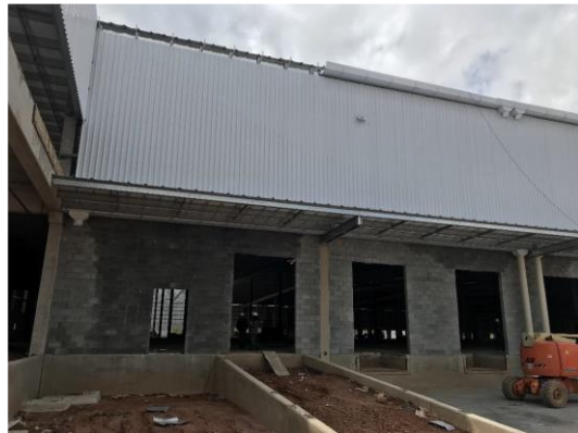
Execução de calhas e marquises
