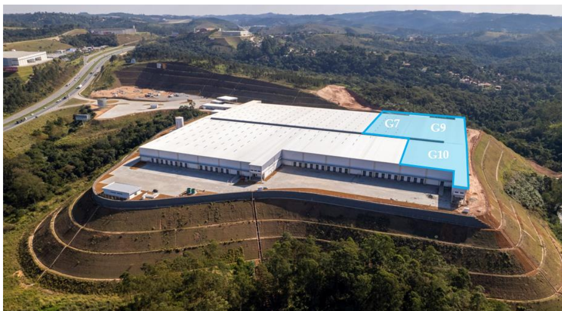
Locação no Galpão 3 (mód. 119 e 120) e renovação no Galpão 2 (mód. 101, 102 e 103), total de 4.530m 2
