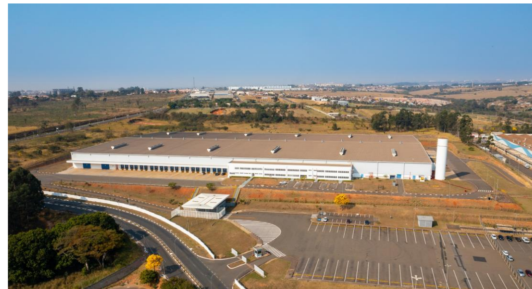
Galpão Hortolândia II Rua Três, 1.028, Hortolândia/SP
