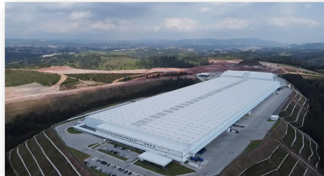
Galpão WT RBR Log (SP) Rod. Pres. Tancredo Neves, km45d
