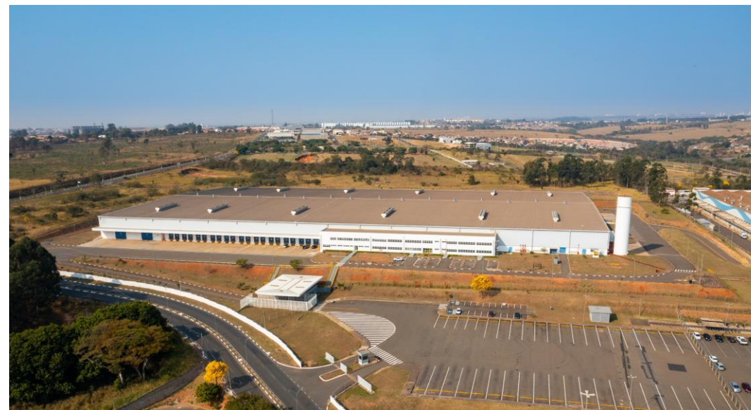
Galpão Hortolândia II Rua Três, 1.028, Hortolândia/SP
