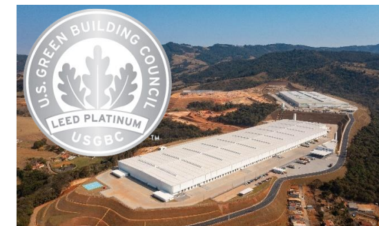
Galpão Extrema I, Extrema/SP
