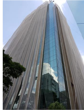
Retrofit da fachada do Ed. Mário Garnero – Torre Sul
