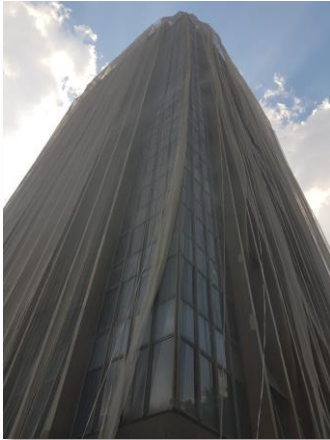
Retrofit da fachada do Ed. Mário Garnero – Torre Sul
