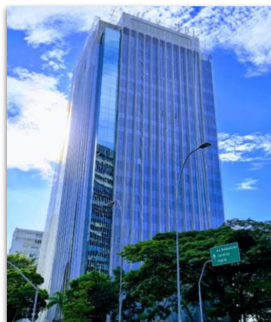
Retrofit da fachada do Ed. Mário Garnero – Torre Sul
