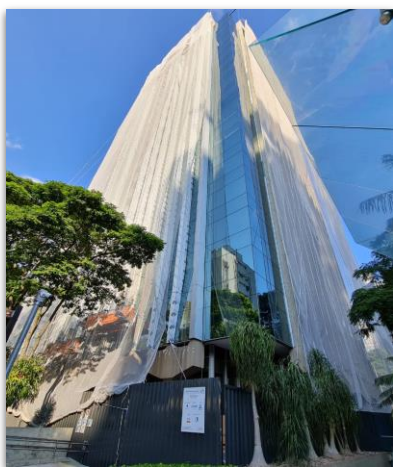
Retrofit da fachada do Ed. Mário Garnero – Torre Sul
