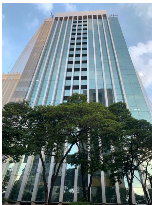
Imagem 3: Fachada do Ed. Mário Garnero
