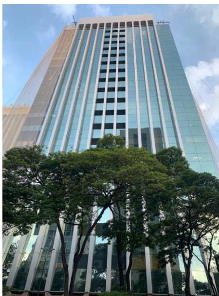
Imagem 5: Fachada do Ed. Mário Garnero
