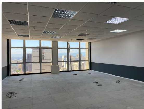
Imagem 5: Obra Ed. Castello Branco
